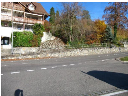
Abbildung 12: Bestand Holmgeländer Bergstrasse
