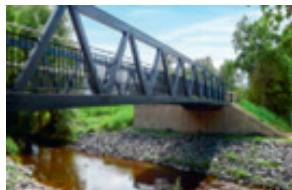
Brücke über Bergstrasse
