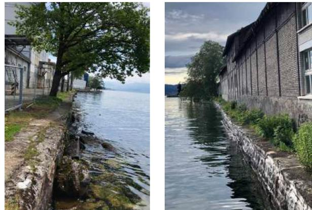
Das Ufer entlang des direkten Seeanschlusses ist mit einer Ufermauer hart verbaut. Die mehrheitlich aus Naturstein erstellte Mauer stellt ein ortsprägendes Element dar. Durch den Blockwurf und einer nicht vorhandenen Flachwasserzone fehlt ein naturnaher Uferstreifen.
